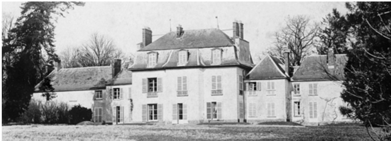
Château primitif démoli en 1902 pour la construction du Sanatorium.
